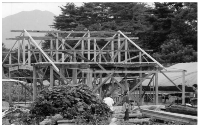
建築中の野原ハウス
