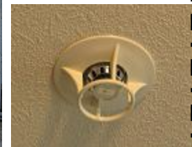
山梨県特別交付金基盤整備事業より 消防機器改修 (スプリンクラー)
